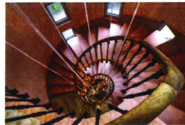
Une exigence des monuments historiques: la couleur d'origine de l'escalier a dû être maintenue.
